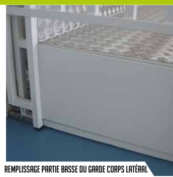
REMPLISSAGE PARTIE BASSE DU GARDE CORPS LATÉRAL
