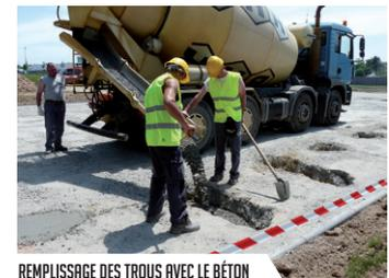
REMPLISSAGE DES TROUS AVEC LE BÉTON
