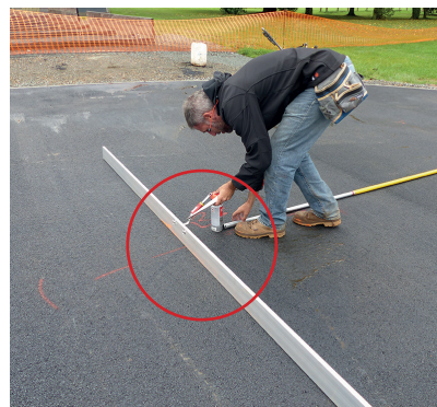
La localisation et l'amplitude de ces zones ont été identifiées à la bombe de chantier sur le site.
