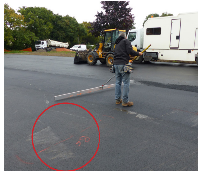
La localisation et l'amplitude de ces zones ont été identifiées à la bombe de chantier sur le site.
