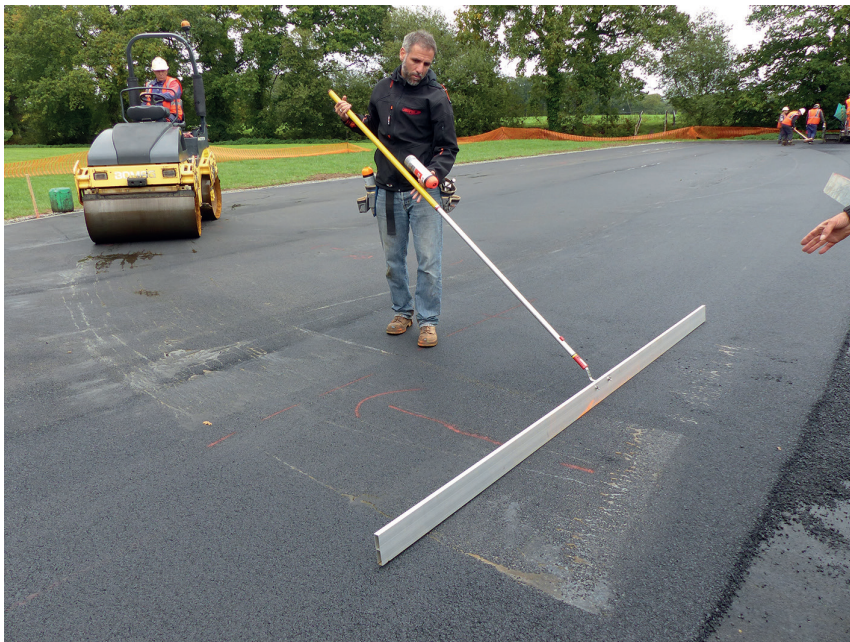
Les flaches et les bosses sont identifiées à l'aide d'une règle de 3 mètres positionnée en tout point
